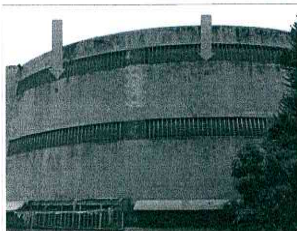
Figura 2: Vista externa dos banheiros, com as chapas metálicas em destaque.
